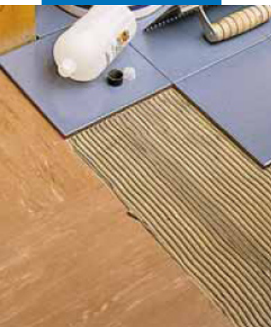
Укладка нового покрытия поверх существующего из ПВХ
