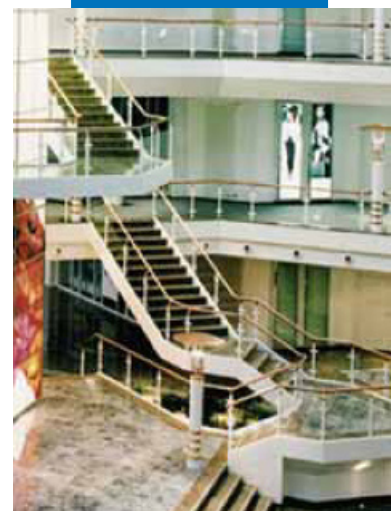
Пример укладки керамических или мраморных полов поверх металлической конструкции (лестница)
