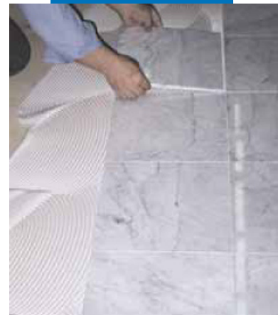
Укладка каррарского мрамора поверх деревянного основания с помощью белого Keralastic
